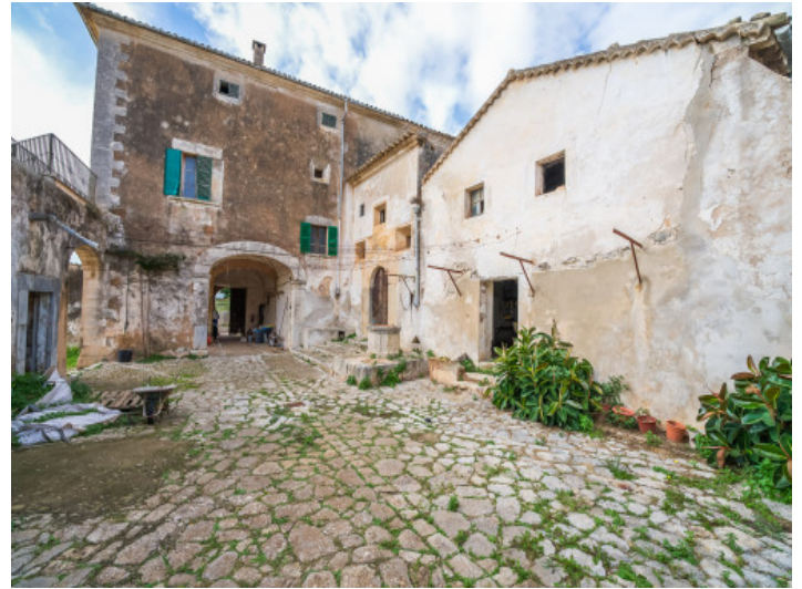
Zugang zur Finca
