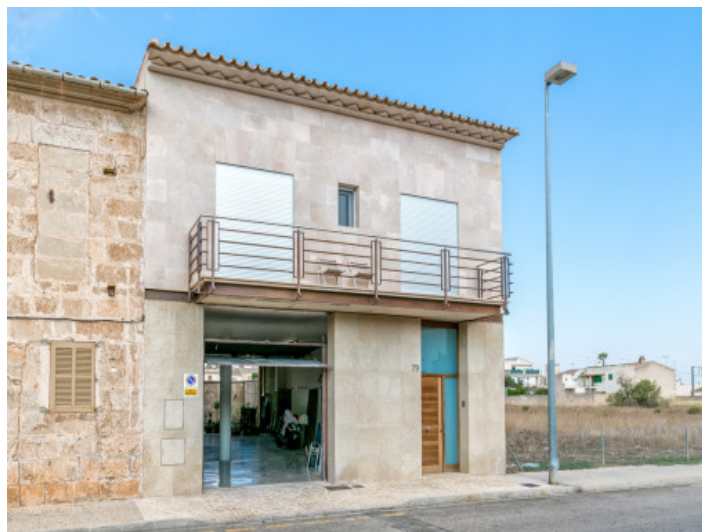
Außenansicht des Dorfhauses
