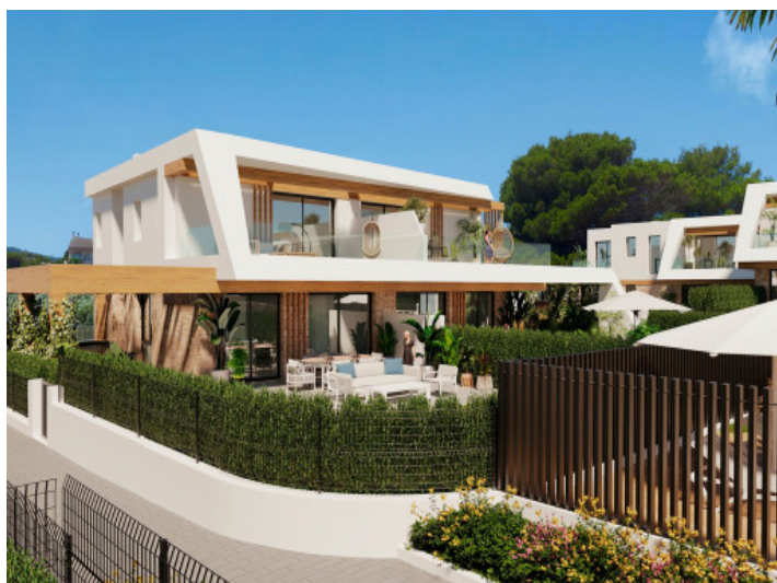
Außenansicht des Reihenhauses
