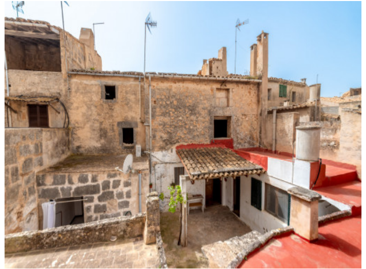
Blick auf den Innenhof
