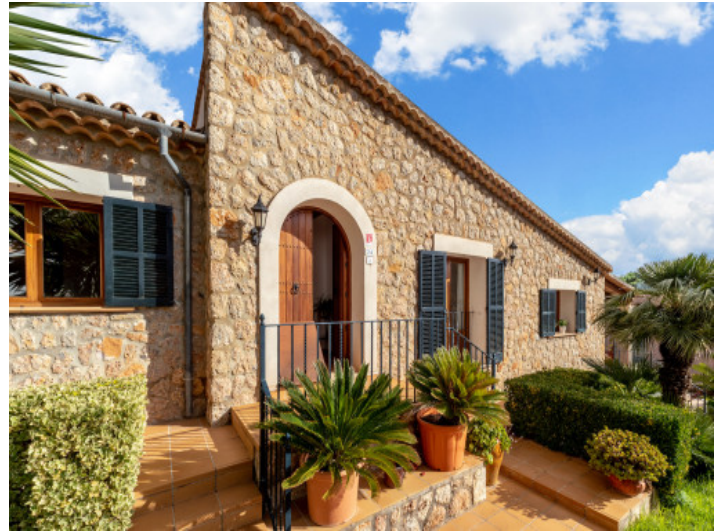
Zugang zum Haus
