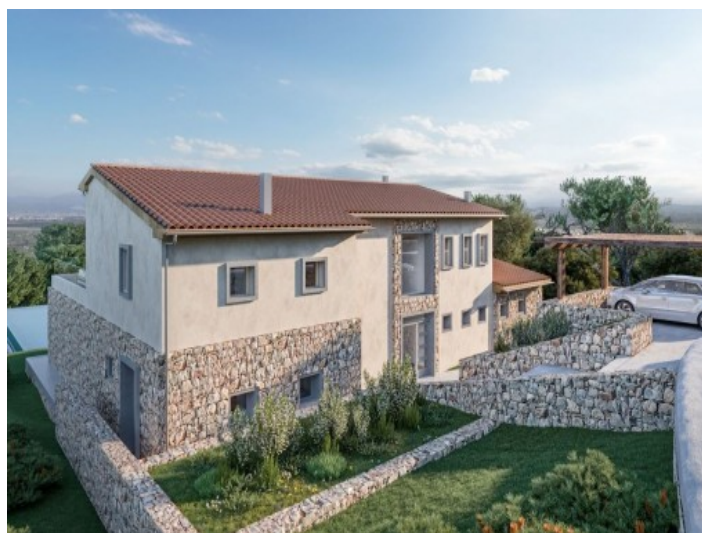
Außenansicht und Zugang
