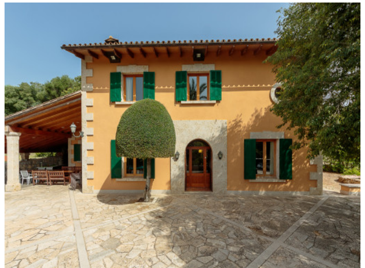
Fassade der Finca
