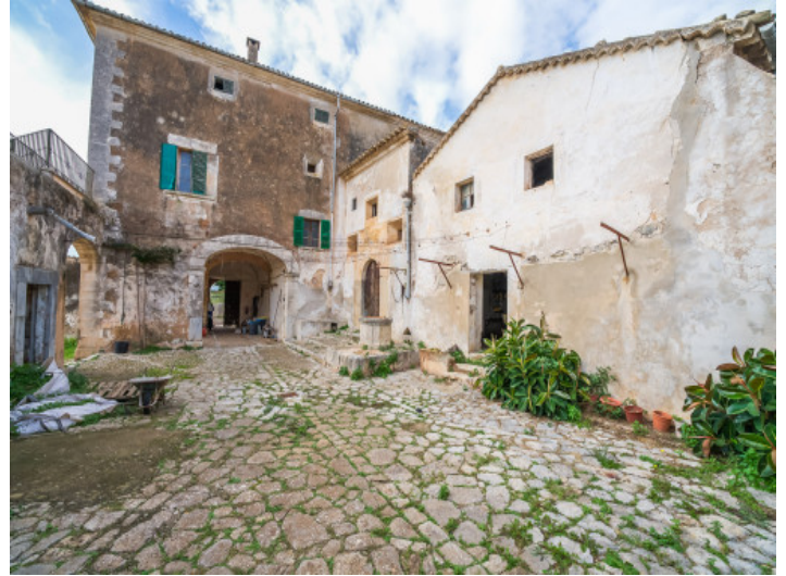
Zugang zur Finca
