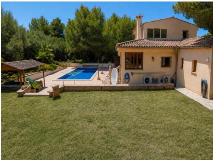
Ansicht vom Garten mit großzügigen Rasenflächen
