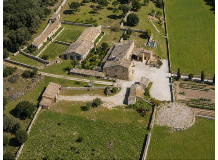
Weitläufiges Anwesen aus der Luft
