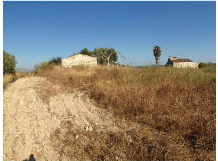
Blick auf das bestehende Gebäude
