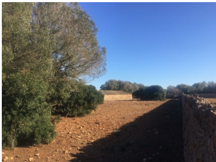
Mauer aus Naturstein
