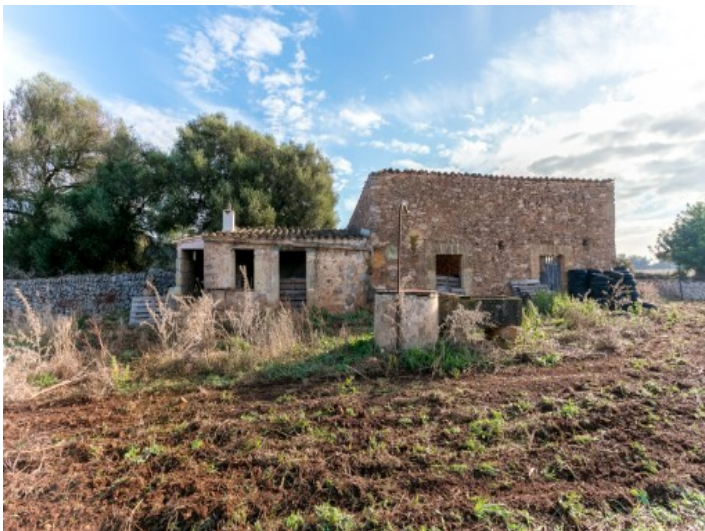
Eines von 2 Gebäuden
