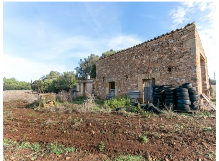
Eines von 2 Gebäuden
