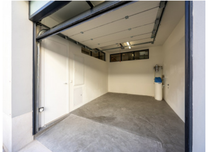
Garage mit E-Ladestation
