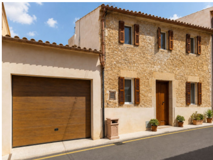
Stadthaus mit Garage
