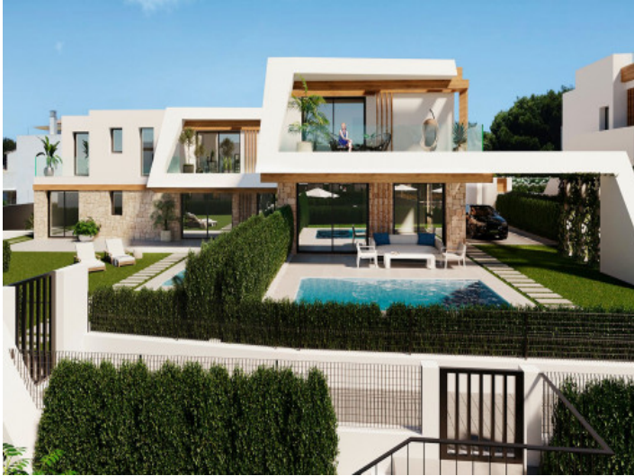
Außenansicht der Doppelhaushälfte
