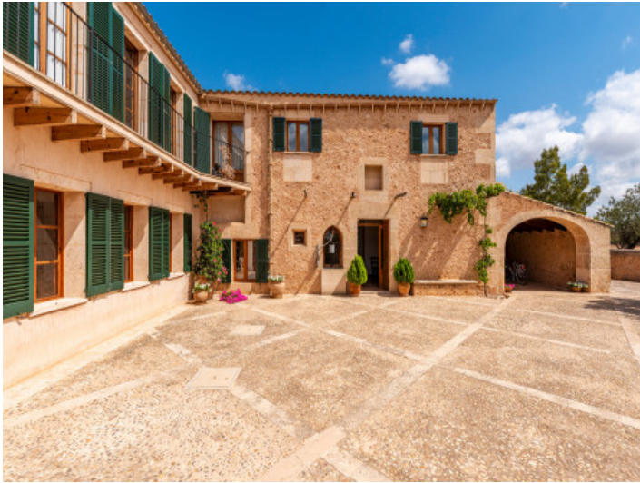
Frontansicht und Zugang der historischen Finca
