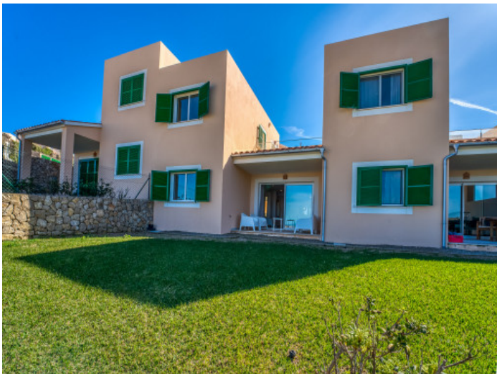
Ansicht auf die Fassade
