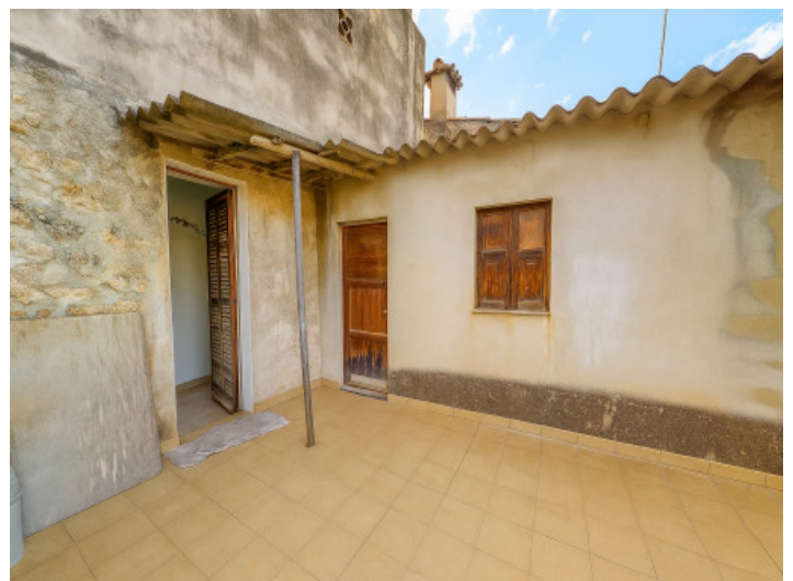
Terrasse des Obergeschosses
