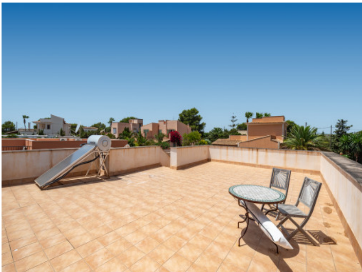
Dachterrasse erstreckt sich über die gesamte Fläche des Hauses
