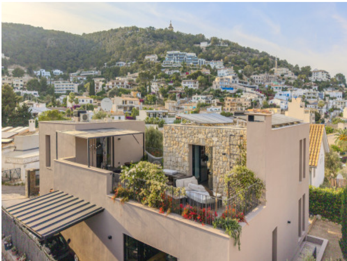
Blick auf die Dachterrasse
