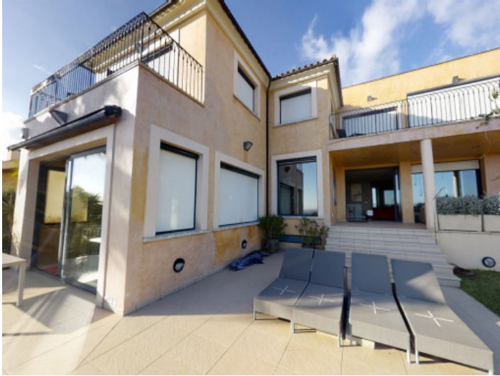
Ansicht der Fassade der Villa
