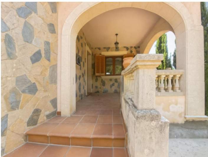
Steinterrasse mit Bogen und Balustrade
