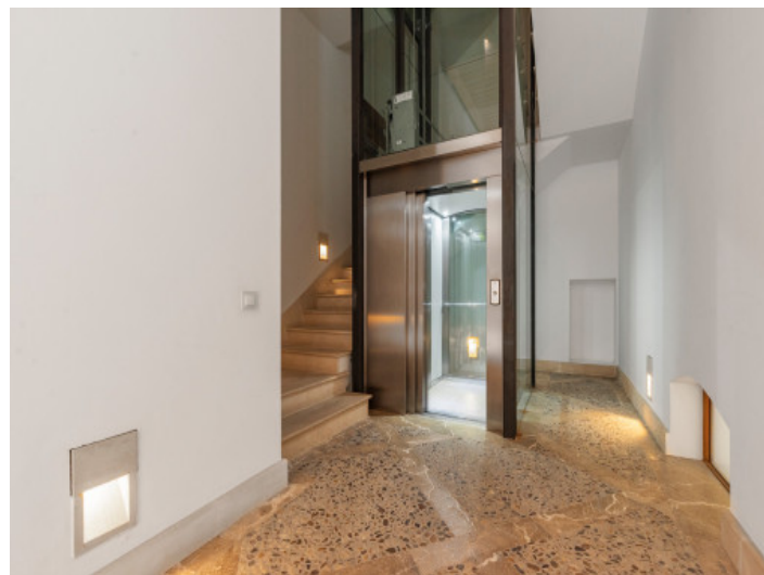
Neuer Aufzug zur Wohnung
