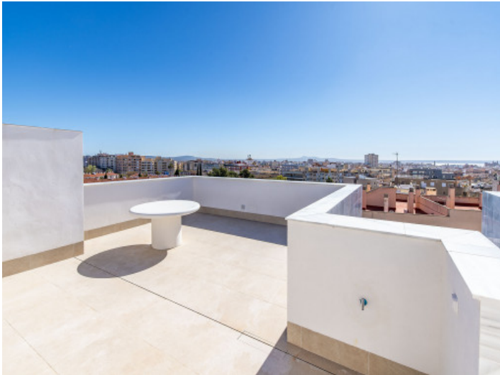
Dachterrasse mit Rundblick
