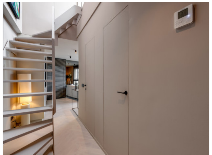
Flur mit Tapetentüren
