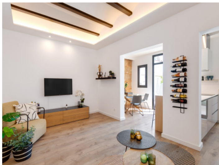
Kappendecke mit indirekter Beleuchtung
