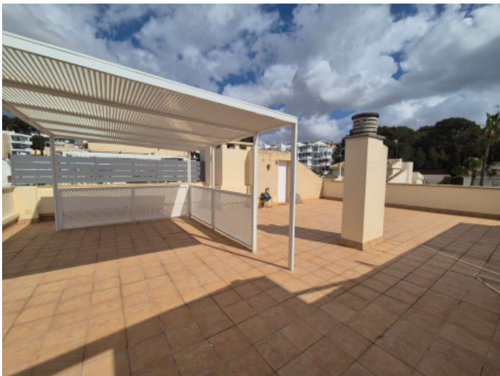
Dachterrasse mit Pergola
