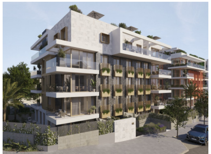
Ansicht des Gebäudes
